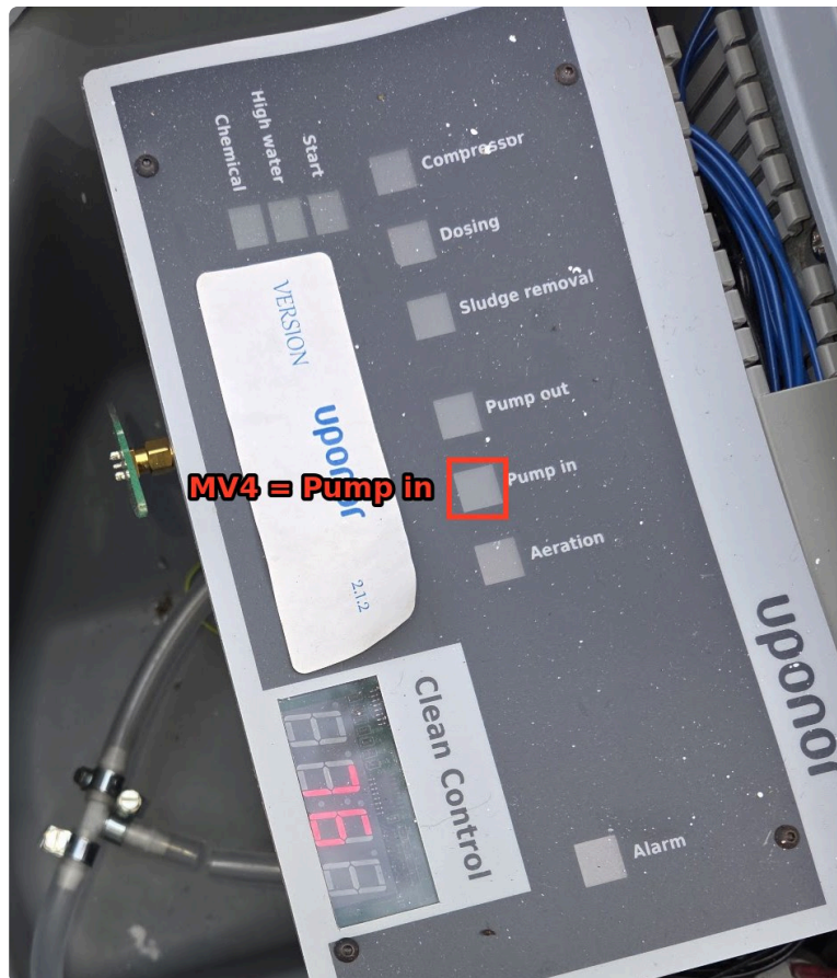
Kotelon kansi: MV4:n merkkipalo on Pump in -ikkuna
